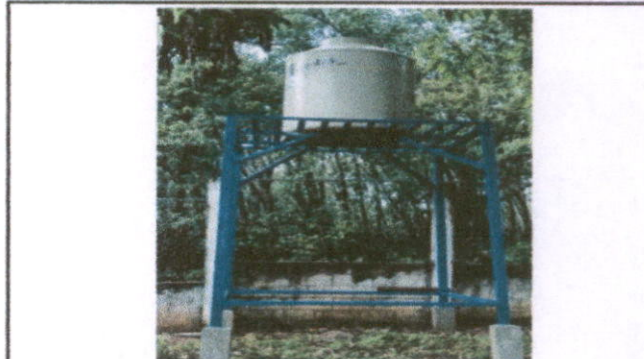
Foto 4: Sustitución de Base de Tinaco
