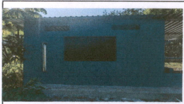
Foto 2: Sustitución de muro de lámina por muro de block en el área de cocina
