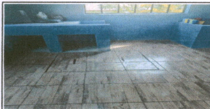
Foto 5: Instalación de Brocal de Pozo y tapadera con cerámico en el área de cocina
